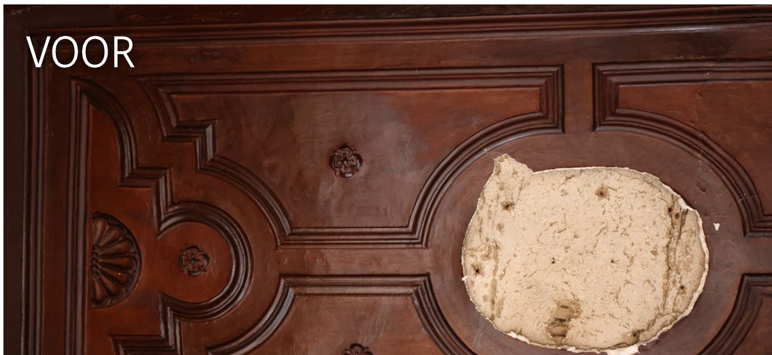
2022: Omdat de onderliggende kalkpleister los was gelaten, viel er in Zwolle een flink ornament uit een plafond van leemstuc
