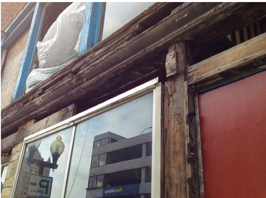
De authentieke puibalk is een belangrijk uitgangspunt voor de restauratie
