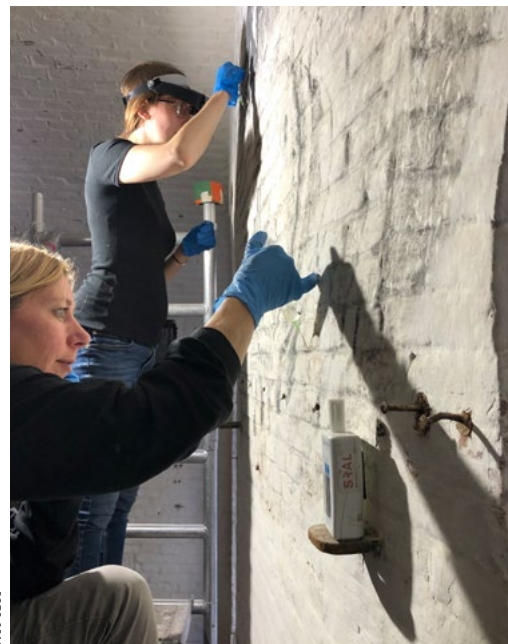
Restauratoren zetten het pleisterwerk achter de teksten en tekeningen vast
