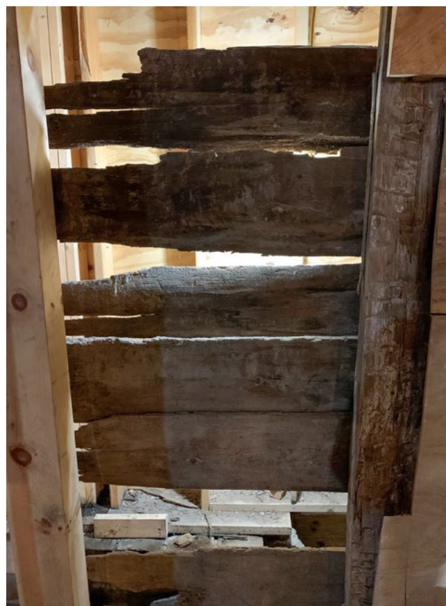
Enkele van de gepotdekselde houten planken waarmee het huis van origine bekleed was
